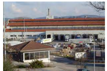
Le site de Charvieu produit les câbles pour le bâtiment.
